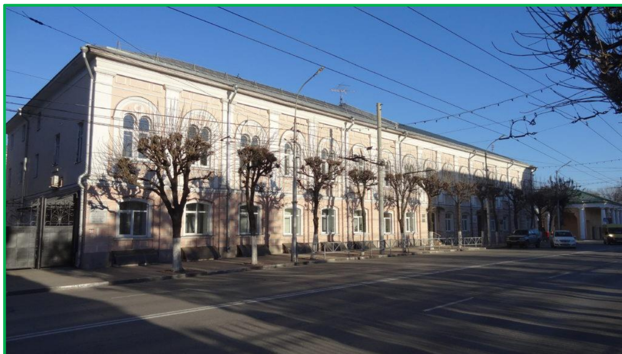
Здание построено в Рязани в 1860 году по проекту губернского архитектора Н.П. Милованова. На втором этаже находились жилые комнаты и залы, на первом — восемь
