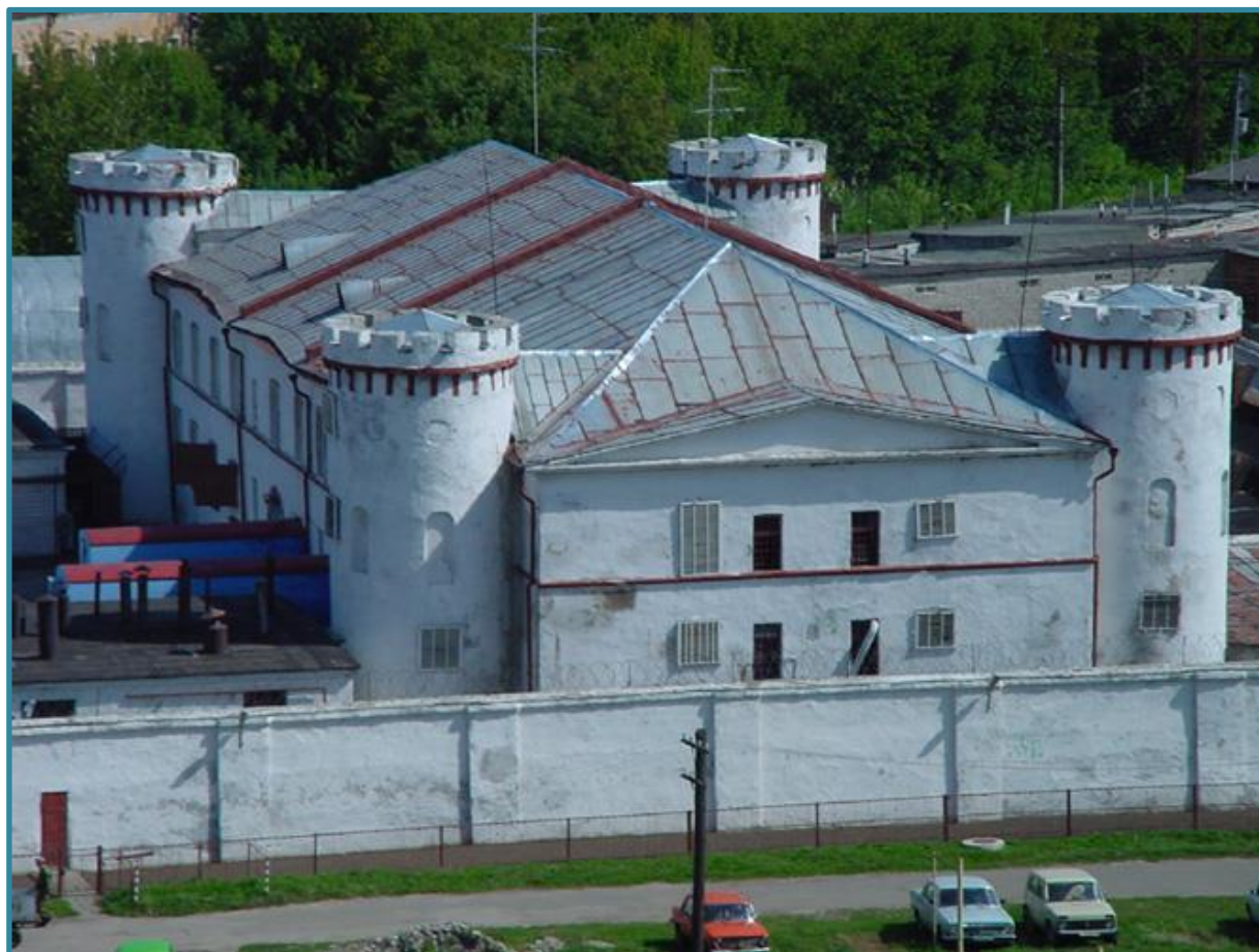
Здание тюремного замка города Рязани. Построено в 1824 году архитектором И.Г. Сулакадзевым и было рассчитано на 300 заключенных.
